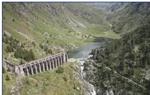
Collasso di una grande diga
